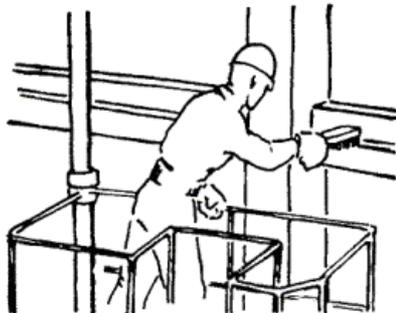
5 УКЛАДКА ПАНЕЛИ; 2,5 мин; М<sub>1</sub>, М<sub>2</sub>, М<sub>3</sub>; ломы, строп
